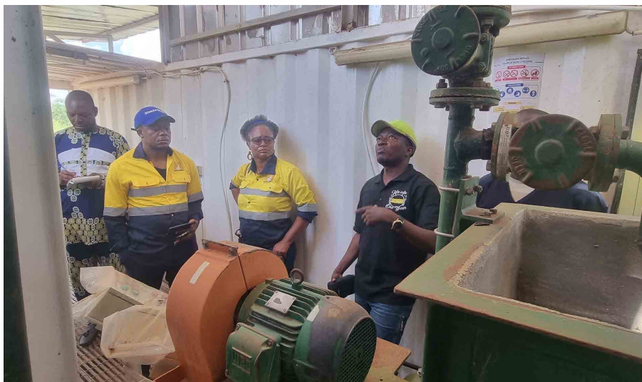
Une mission conduite par le Directeur Général de la SONAMINES a séjourné à Akonolinga le jeudi 5 septembre 2024, à l'effet d'apprécier les travaux et la qualité des installations de l'ancien opérateur ERAMET.
